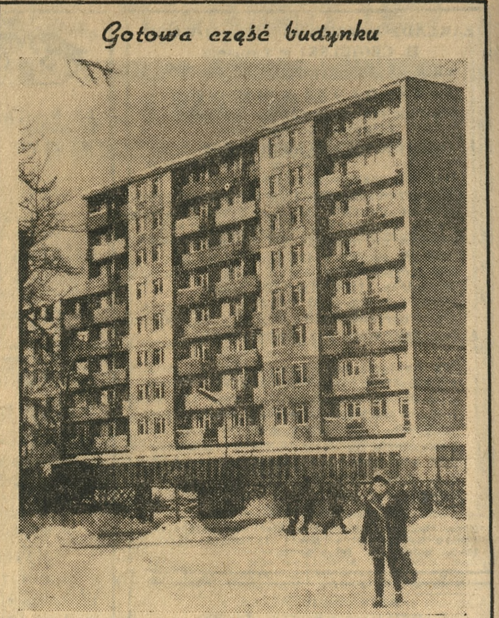
Gotowa część budynku
