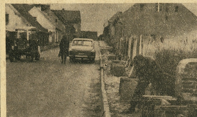
Układanie płyt chodnikowych na ul. Szamotulskiej.
