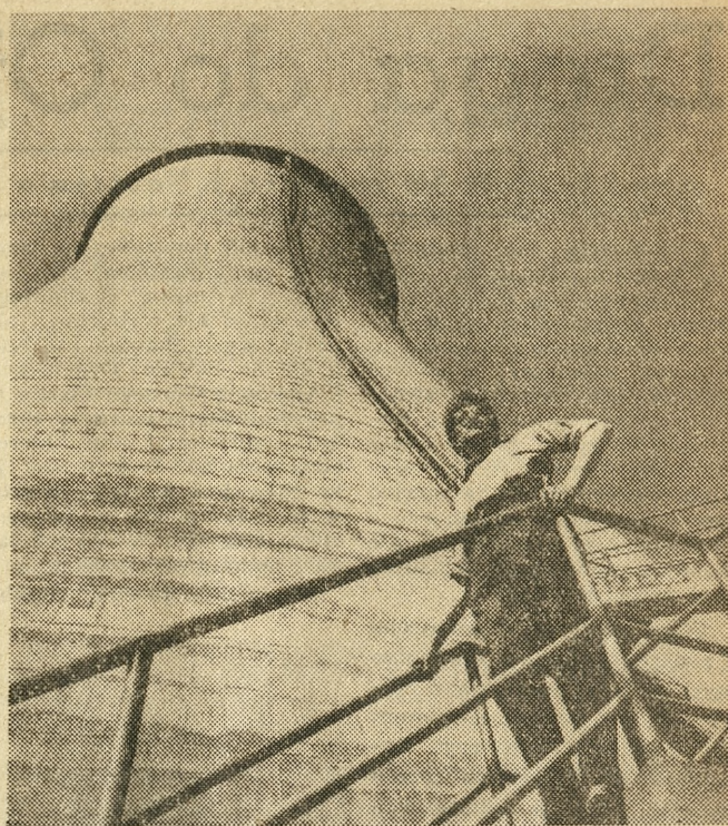
Inż. Bronisław Czerniewski, sprawujący nadzór nad budową chłodni kominowych, jest wyraźnie zadowolony — roboty wykonano w terminie, a ich jakość budzi podziw wśród licznych tu fachowców z innych krajów.
