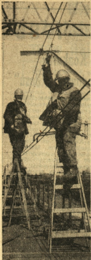
Zawieszanie przewodów to już końcowy etap robót elektryfikacyjnych. W tych czynnościach specjalizuje się brigada sieciowa Kazimierza Drążka (na zdjęciu), którą zastaliśmy przy pracy na odcinku pomiędzy Puszczykówniem a Mosiną.
