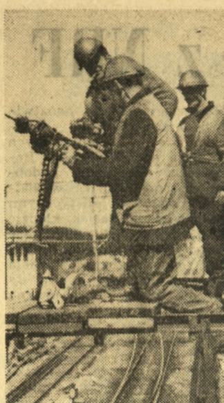
Montaż sieci napowietrznej odbywa się stosunkowo szybko, ale jednak wymaga dokonania wielu skomplikowanych czynności. Na zdjęciu: zakładanie izolatorów.
