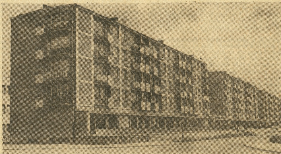
W latach 1965-1968 wybudowaliśmy ogółem około 62 000 nowych izb mieszkalnych, uwzględniając szczególnie potrzeby rozwijających się nowych ośrodków przemysłowych. Na zdjęciu nowe bloki mieszkalne w Lesznie.
