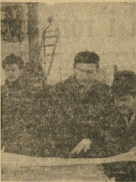
Przed rozpoczęciem pracy na budowie uczniowie są instruowani o tym, co będą wykonywać tego dnia. Objaśnień udzielają kierownik praktycznej nauki zawodu inż. T. Adamski (od prawej) i instruktor, mistrz budowlany - T. Spychała.
