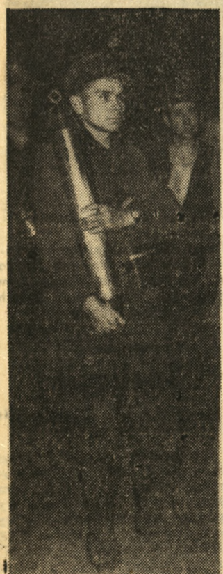
Na zdjęciu: ratownicy z pojeźnikami, w których opuszczano żywność więzionym górnikom.
