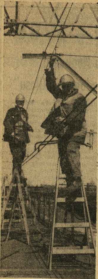
Zawieszanie przewodów to już końcowy etap robót elektryfikacyjnych. W tych czynnościach specjalizuje się brygada sieciowa Kazimierza Drążka (na zdjęciu), którą zastaliśmy przy pracy na odcinku pomiędzy Puszczykówkiem a Mosiną.
