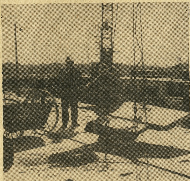
Brygady montażowe mają pełne ręce roboty. Od nich też zależy postęp innych prac budowlanych, przede wszystkim wykańczanie wnętrza budynków. A na prace wykończeniowe potrzeba więcej czasu, niż na montaż budynków. Większość tych prac odbywa się bowiem metodą tradycyjną.
