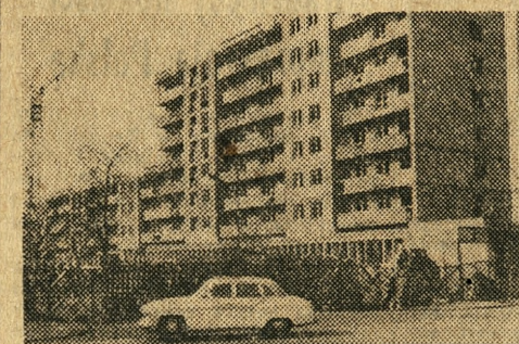
Coraz więcej nowych obiektów powstaje w centrum miasta. Przy ul. Powstańców Wielkopolskich rosną mury domu mieszkalnego dla Spółdzielni Mieszkaniowej „Grunwald”. Fot. — K. Przychodźki
