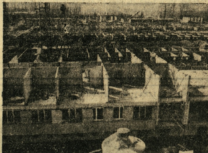
Nadwarciańskie Rataje zamieniły się w ogromny plac budowy. Obrazuje to najlepiej powyższe zdjęcie.
