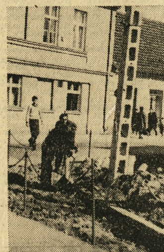
Ojciec i syn Napierałowie przy układaniu krawężników.
