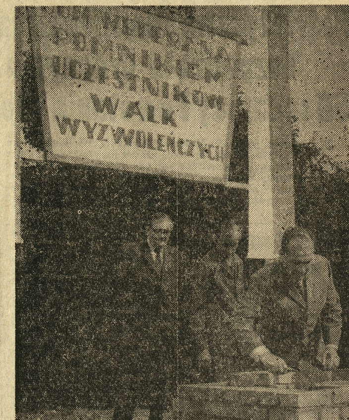
I sekretarz KW PZPR — Jan Szydłak dokonuje wmurowania aktu erekcyjnego pod „Dom Weterana”. Fot. — E. Kitzman
