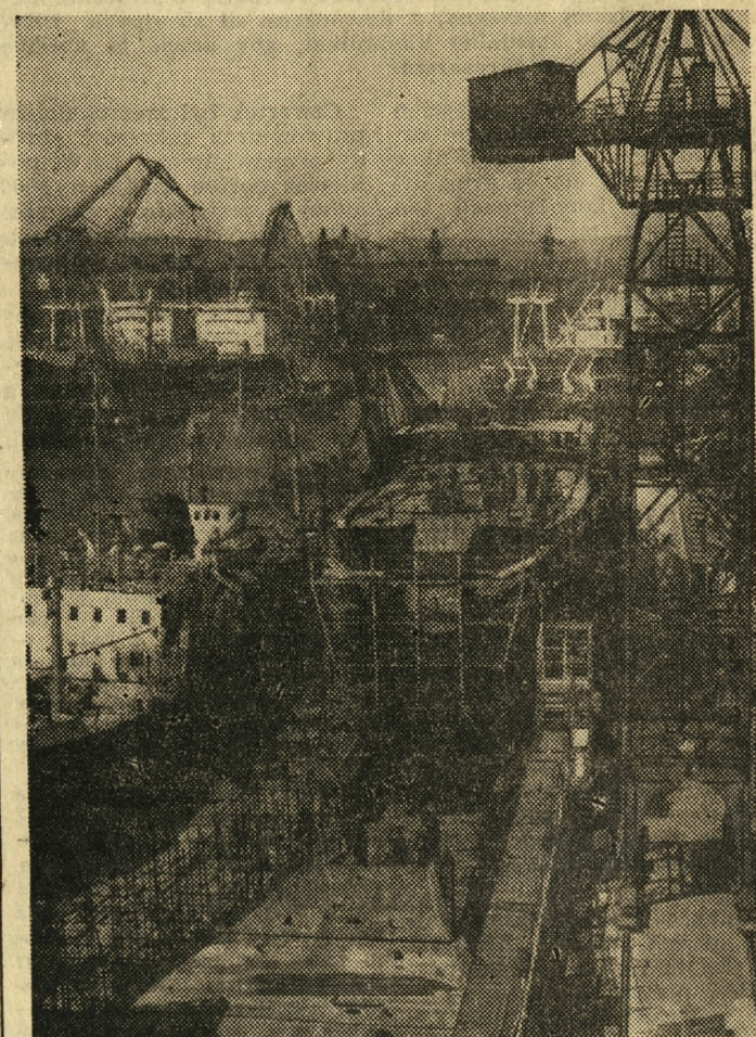
Stocznia Gdańska im. Lenina. Montaż drewnowca B/45/66 dla armatora radzieckiego i trawlera przetwórci B-26.
