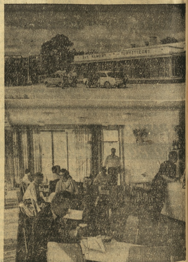
Gdynskie Zakłady Przemysłu Terenowego uruchomiły nową stację obsługi pojazdów mechanicznych, usytuowaną przy głównej arterii przelotowej w Gdyni-Orłowie. Można tu dokonać remontu i przeglądu samochodów marki „Warszawa”, „Syrena”, „Mazda” i „Skoda” a za parę dni także „Volkswagen” — na zastanie serwisu fabrycznego. Stacja czynna jest do późnych godzin wieczornych. Właściciele pojazdów oczekujący na dokonanie drobnych napraw czy zatankowanie benzyny mogą wypić herbatę, kawę czy zjeść gorący posiłek w estetycznie urządzonej barze przy stacji. Na zdjęciu (głównie) nowa stacja obsługi samochodów w Gdyni-Orłowie.
