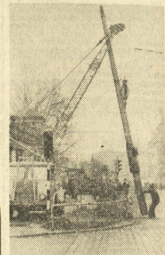
W związku z przebudową placu Wolności trzeba było usunąć m.in. słupy oświetleniowe (na zdję-ciu), które przeszkadzały w po-szerzeniu jezdni.
