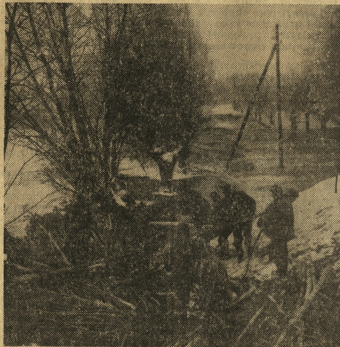
Na zdjęciu: prace przy rekonstrukcji wału przeciwpowodziowego we wsi Górecko.
