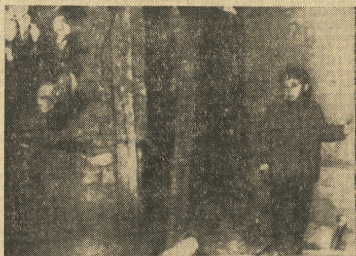
Dnia 30 ubm. silne trzęsienie ziemi nawiedziło jugosłowiańskie miasteczko Debar położone w zachodniej Macedonii. Prawie wszystkie domy uległy zniszczeniu. Liczba ofiar nie jest jeszcze znana. Na zdjęciu: chłopiec przy ruinach swego domu.
