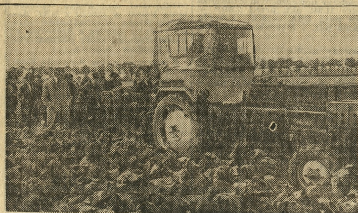
A oto wyrywacz i ładowacz korzeni „Orlik” z zestawu do dwufazowego zbioru buraków, produkowany przez słupską fabrykę, zaprojektowany przez konstruktorów z poznańskiego PIMR. Zestaw ten najbardziej odpowiada naszym pegerowcom; może zebrać dziennie plon z 8 hektarów.
