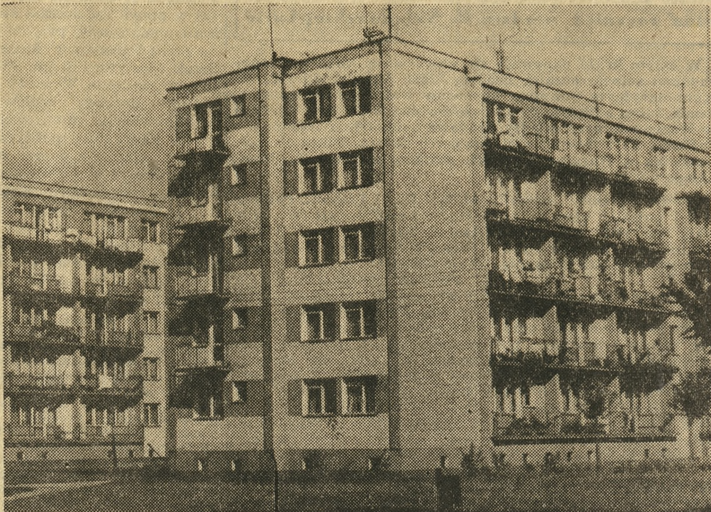
Bloki mieszkalne wrzeńskiej spółdzielni mieszkaniowej przy ul. Wojska Polskiego.
