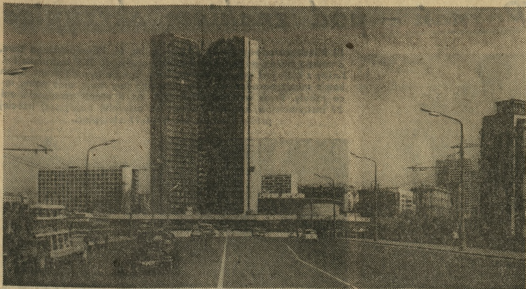
Nowa siedziba RWPG. Widok z Prospektu Kutuzowa.
