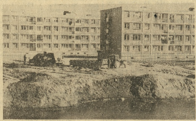
Trwają prace przy wznoszeniu coraz to nowych bloków na kaliskim osiedlu „Kaliniec”. Na zdjęciu: brygady robotnicze przygotowują teren pod budowę. Już niedługo ostatni z kilku stawów zostanie zasypyany ziemią, a na jego miejscu stanie blok, lub skwerek. (mat.) Fot. — K. Kordes
