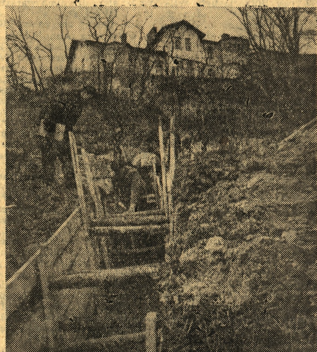
Pracownicy Rejonowego Przedsiębiorstwa Melioracyjnego w Sandomierzu zakładają sączki ceramiczne w 35-metrowym wykopie. Prace te mają na celu odwołanie skarpy.
