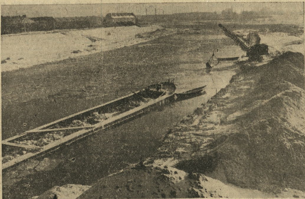
Kra lodowa — wynik trwających od kilku dni mrozów — płynie nie tylko korytem Warty, ale pokrywa również nowe koryto rzeki, będące obecnie w budowie. Mimo to nie przerwano tutaj prac. Koparka pogłębiająca dno koryta pracuje niemal bez przerwy. Na zdjęciu — widok nowego koryta. Na drugim planie pracująca koparka. Fot. — K. Przychodźki
