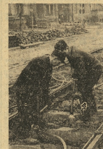
Za pomocą pneumatycznych pod- bijarek pracownicy MPK wyrów- nują tu podkłady pod nowy tor tramwajowy. Fot. (3) — K. Przychodźki
