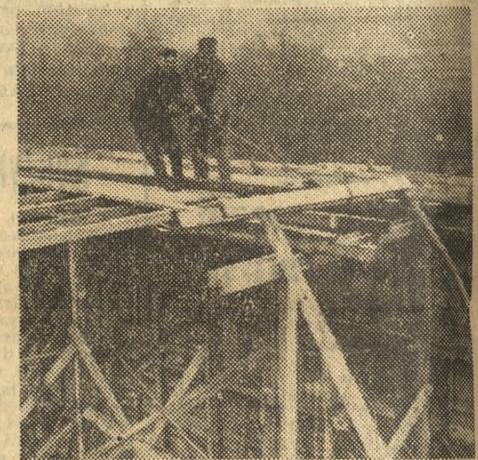
Na budowie muru oporowego w pobliżu Mo- stu Teatralnego.
