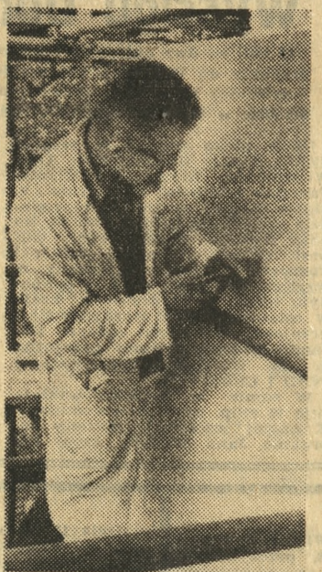
Prace przy łączeniu płyt blachą ołowianą.
