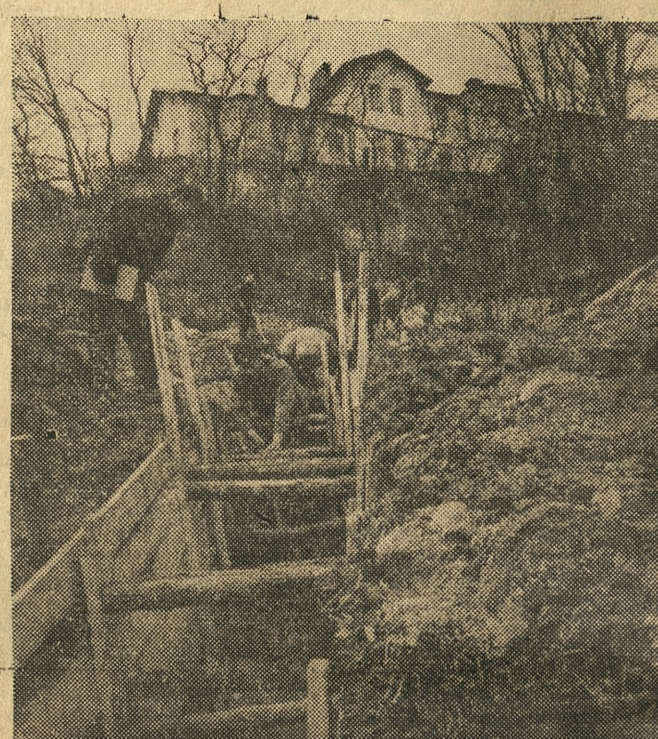
Pracownicy Rejonowego Przedsiębiorstwa Melioracyjnego w Sandomierzu zakładają sączki ceramiczne w 35-metrowym wykopie. Prace te mają na celu odwodnienie skarpy.
