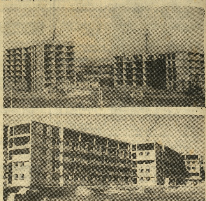
Na zdjęciu górnym — pierwsze z dwóch wieżowców powstających przy ul. Krańcowej, na dolnym — budynek mieszkalny na osiedlu na Winiarach, które buduje Poznańskie Przedsiębiorstwo Budowlane nr 3. Fot. (2) — K. Przychodzki
