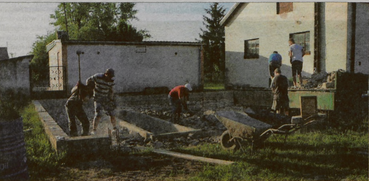
Przy budowie nowych garaży praca wre.
