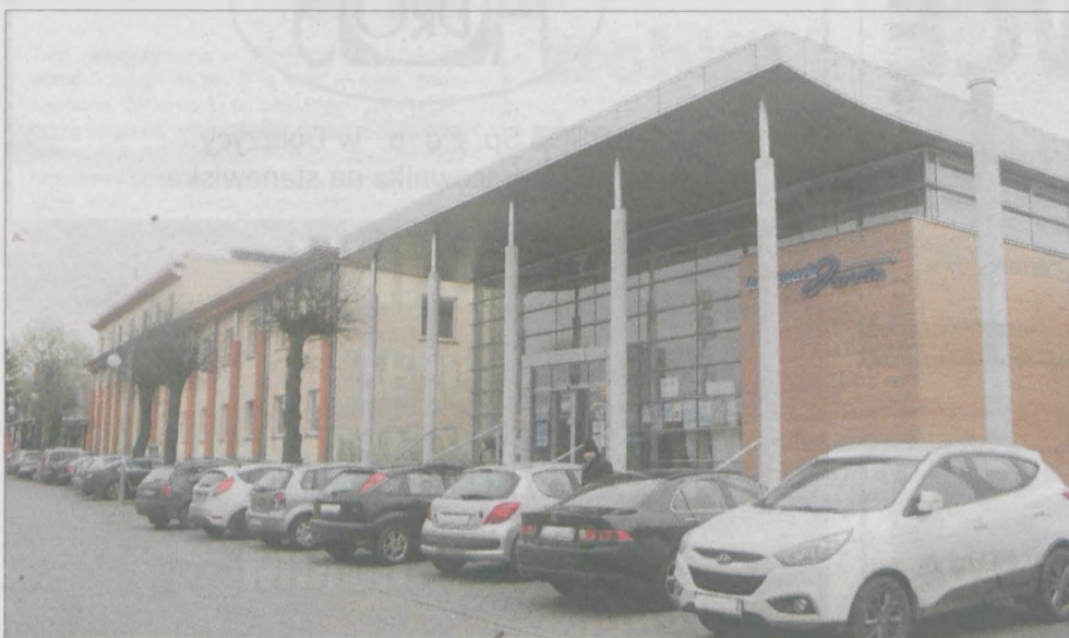
Pond 2 tys. m 2 powierzchni zajmą nowo wybudowane obiekty Jarocin Sport
