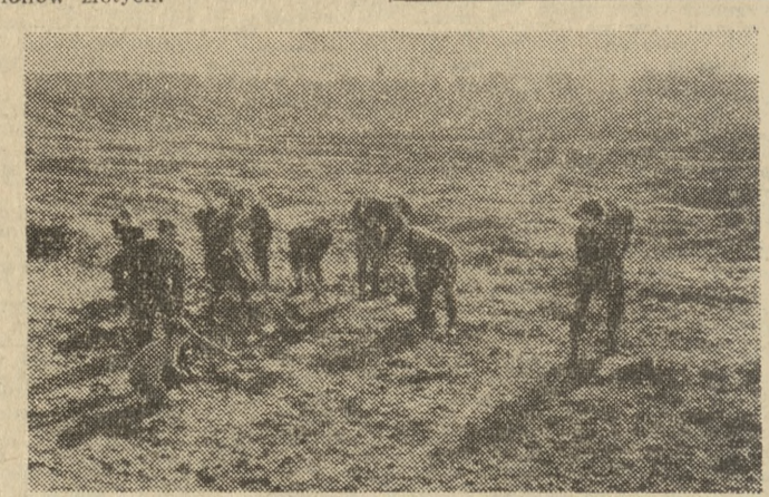
Zarysowują się pierwsze kontury budującego się stadionu WKS Grunwald przy ul. Promienistej. Przy pracach, prowadzonych w dużym stopniu w czynie społecznym, zatrudnieni są wojskowi i okolica młodzież.
