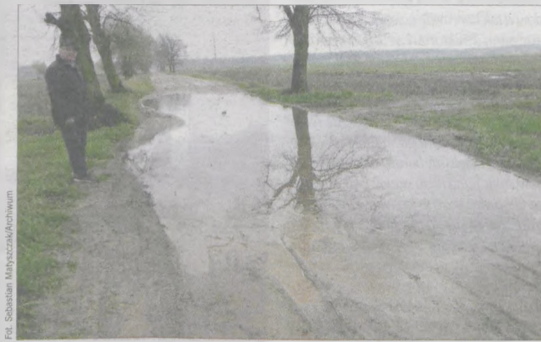
Radny Marian Grześkowiak od wielu miesięcy apeluje o poprawę stanu drogi
