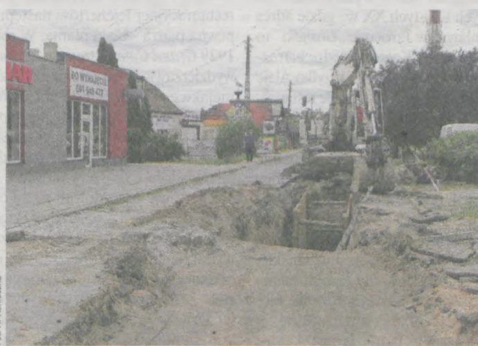
Przedsiębiorstwo Wodociągów i Kanalizacji rozkopało ul. Węglową w Jarocinie, żeby pobudować nowe sieci - wodociągową, kanalizacyjną i deszczową
