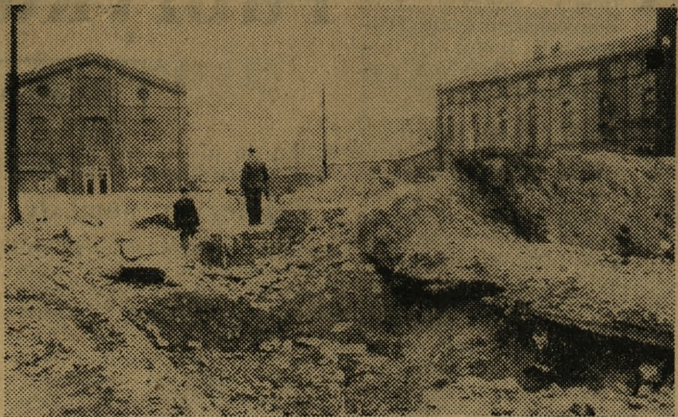
Ma narożniku ulic Ratajezaka i Powstańców Wielkopolskich przystąpiono niedawno do likwidacji istniejących tam starych szop i magazynów. W przyszłości ma tu stać wielki blok mieszkalny. Na zdjęciu — obecny stan prac rozbiórkowych.
