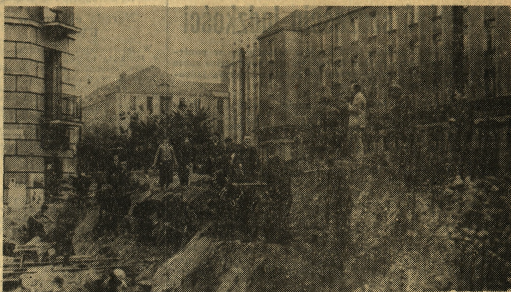
Wróg zbliża się do stolicy, kto żyw rusza do budowy barykad. Na zdjęciu: budowa barykady na ul. Targowej.
