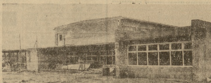
Dom Kultury w Damasławku gotowy — w stanie surowym. Fot. (2) — K. Przychodźki
