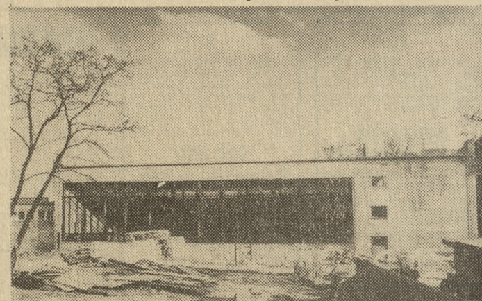
Poznańskiej młodzieży szkolnej przybędzie w najbliższych dniach nowy piękny obiekt rekreacyjno-sportowy. Jest nim nowoczesna sala gimnastyczna przy Szkole Podstawowej im. Powstańców Wielkopolskich na ul. Artyleryjskiej.
