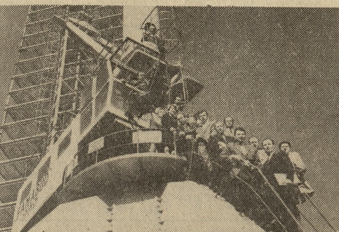
A oto zdjęcie załogi warszawskiego „Mostostalu”, która na trzy dni przed pierwszomajowym świętem ukończyła montaż konstrukcji i półfabrykatów drugiego wieżowca na wschodniej stronie ulicy Marszałkowskiej.
