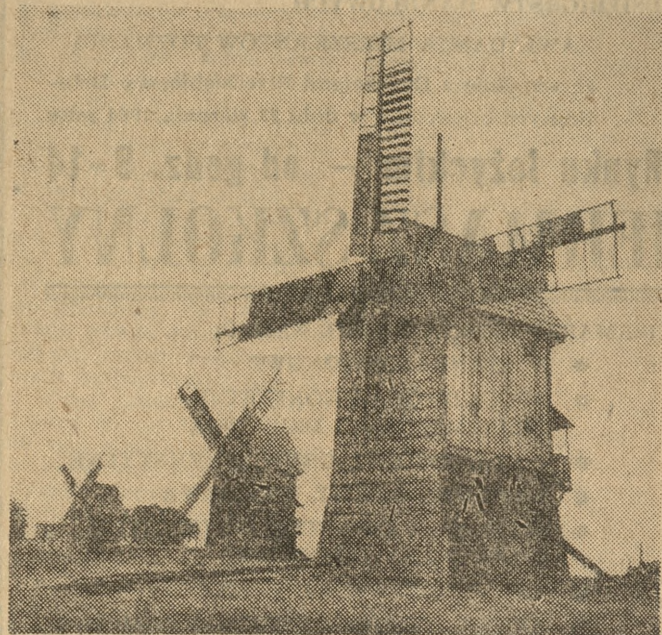
W miejscowości Osieczna [woj. poznański] pozostały już nieliczne na tym terenie, ale stale jeszcze czynne wiatraki. Jest ich trzy. Pierwszy z nich, największy liczy sobie już ponad 200 lat — jest już zabytkiem pod ochroną. Przed pół wiekiem stało w tym miejscu siedem wiatraków.
