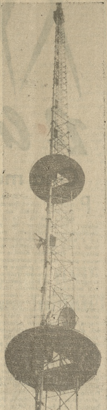
Maszyn nadawczy Ośrodka Telewizyjnego w Górze koło Śremu. Wysokość 280 metrów. Fot. (2) — K. Przychodźki
