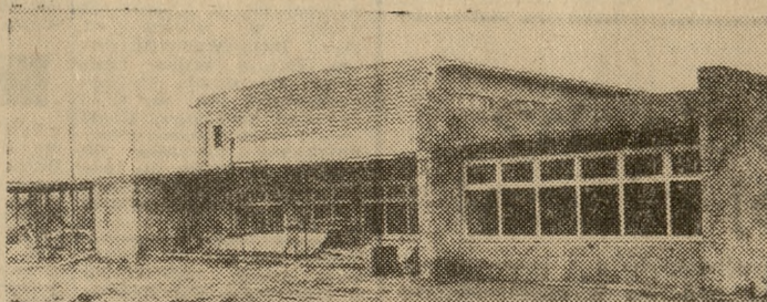
Dom Kultury w Damasławku gotowy — w stanie surowym.
