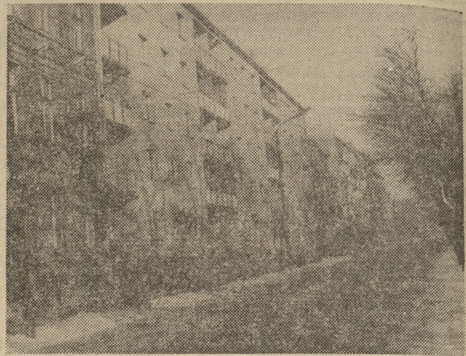
W szybkim tempie rozbudowuje się mieszkania w Gnieźnie. Na zdjęciu nowe domy przy ul. J. Sobieskiego. Fot. — Janusz Chłosta
