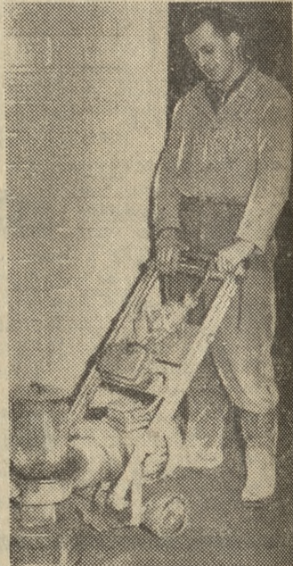
Lastrikarz — Stanisław Juchacz szlifuje posadzkę w pomieszcze- niu pralniczym.
