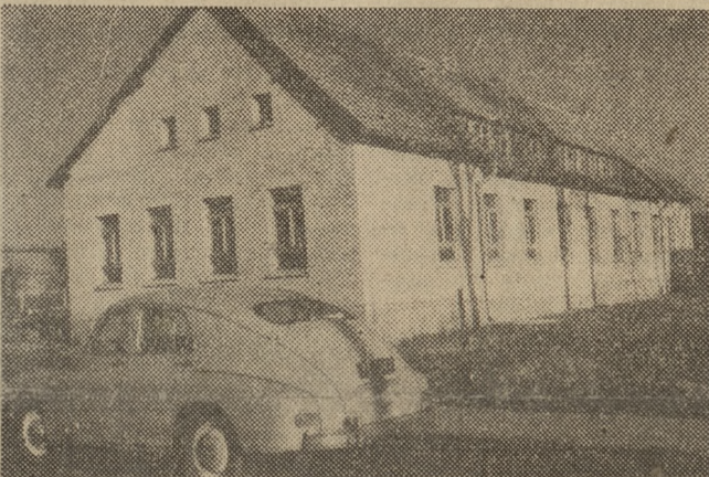
Tak wygląda budynek izby porodowej w Wielichowie, budowanej z inicjatywy i w większości ze środków społecznych ludności. O inicjatywach powiatu kościańskiego piszemy na stronie 4.
