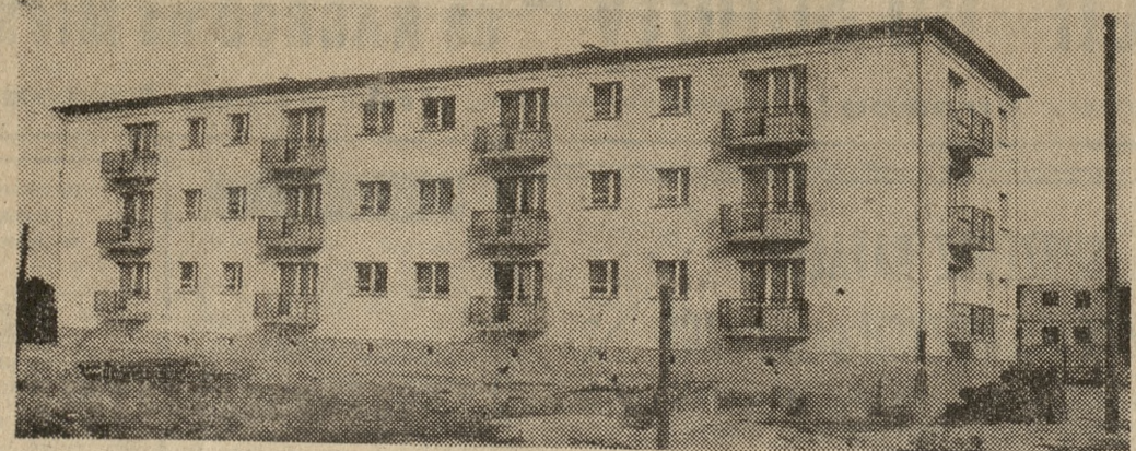
We wszystkich niemal większych miastach Wielkopolski buduje się wielopiętrowe bloki mieszkalne. Na zdjęciu: nowe bloki w Szamotułach. Fot. — K. Przychodźki
