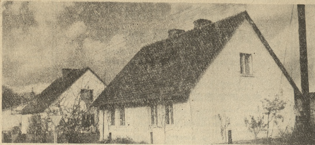
W Głuchowie (powiat kościański) powstało gospodarstwo wieloobiektywne. Zwiedzał je ubiegłej soboty Marszałek Polski Marian Spychalski. Obok obiektów gospodarskich, zwracają tam uwagę domki dla pracowników PGR, widoczne na naszym zdjęciu.
