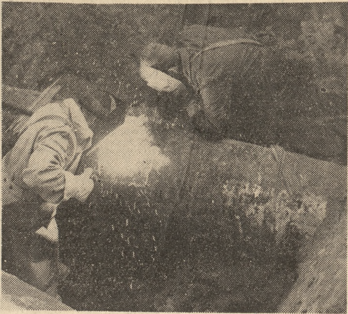
W ostatnich dniach polski odcinek rurociągu „Przyjaźń” został połączony z NRD-owskim. Skończył się jeszcze jeden etap tej największej inwestycji krajów RWPG. Na zdjęciu: spawacze dwu odcinków rurociągu „Przyjaźń”.
