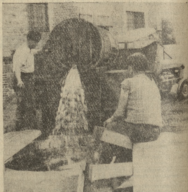
W taki oto sposób radzono sobie z brakiem wody w PGR Próchno pod Chodzieżą. Przywożono na bezkrowozem wodę wlewaną do studni, skąd czerpano ją do bieżących potrzeb gospodarki.
