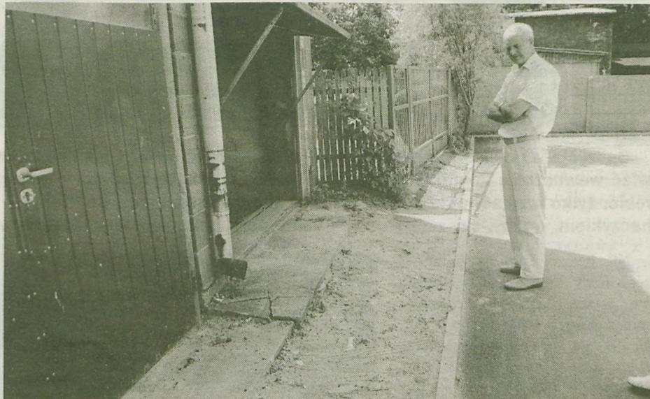
Burmistrz Piątkowski przygląda się wjazdowi do garażu. Pana Stawicki po budowie drogi nie ma możliwości wyjazdu wózkiem inwalidzkim.
