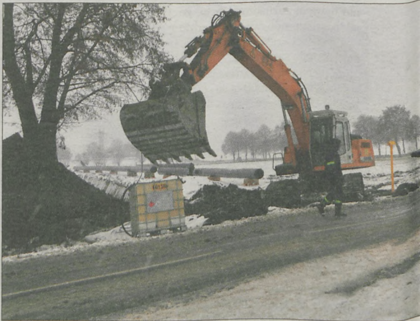
Czy szybkość z jaką realizowana jest ta gazowa inwestycja może sugerować przed tygodniem widać rozmieszczanie rur przy drodze 470.
