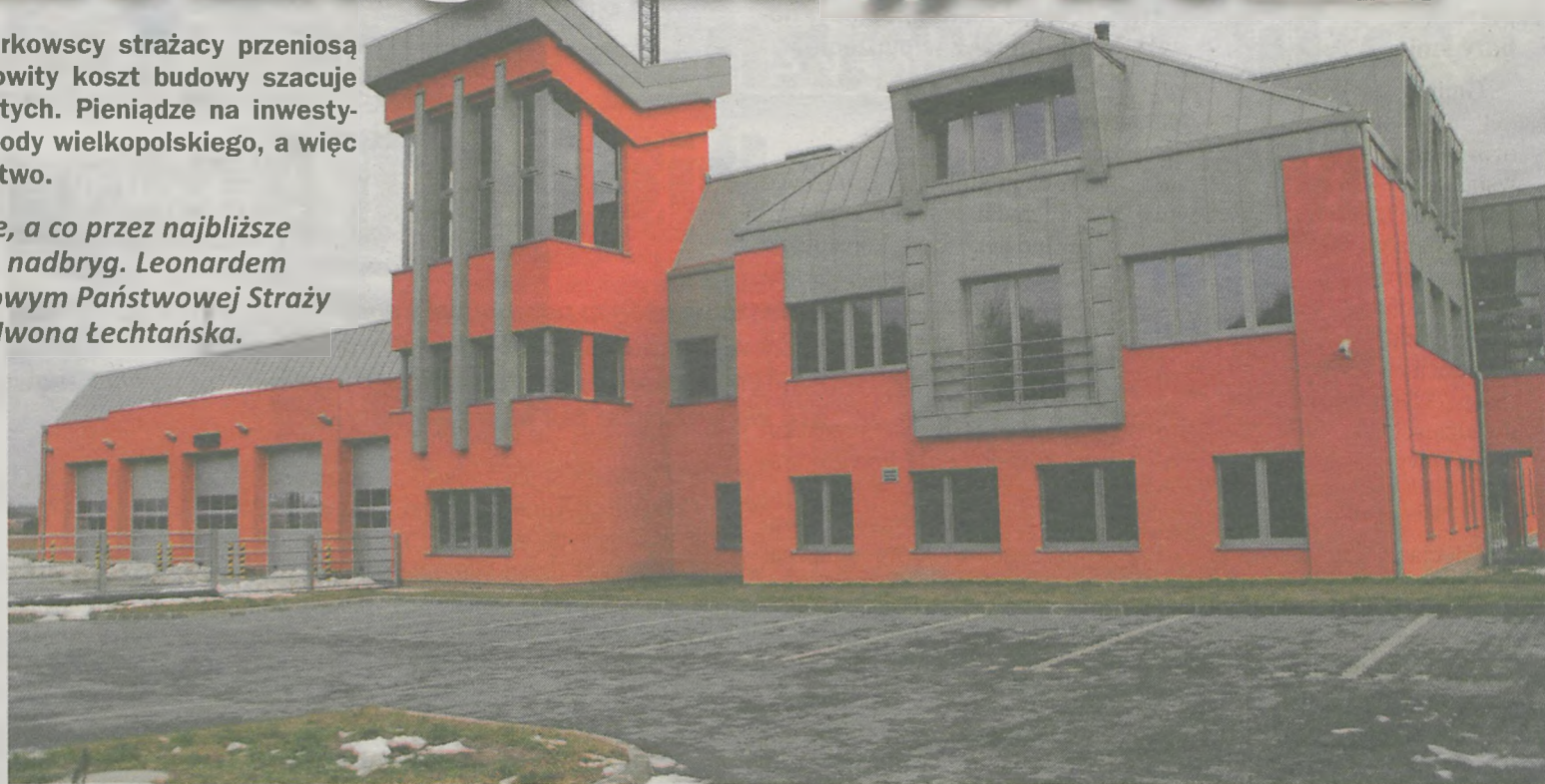
Powierzchnia strażnicy przy ul. Działkowej, to ponad cztery tysiące metrów kwadratowych. Budynek robi wrażenie zarówno ze względu na wielkość, jak i kolorystykę.
