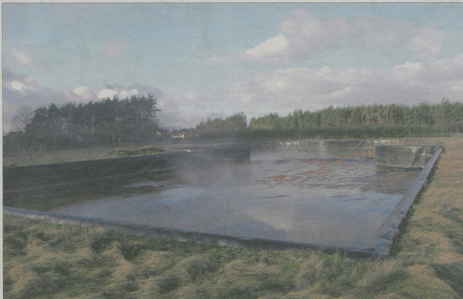
Basen przy Kościelnickiej z przebiegającą obok (widoczna na drugim planie) linia wysokiego napięcia.
